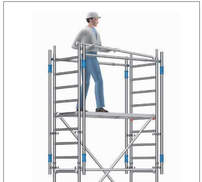
Bild 6: Sichere Montage der Geländer mit MSG
